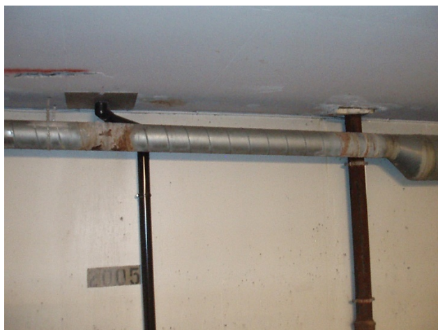
Rusten ventilasjonskanal
