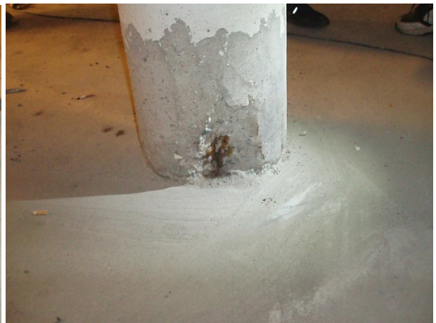
Skade i bunn søyle over dekke over nedre parkeringskjeller
