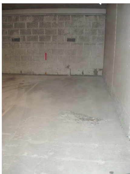
Bildene over viser noen av avdekkede skader i overkant dekke
