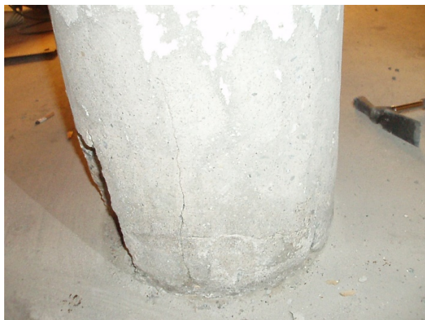
Skade i bunn søyle over dekke over nedre parkeringskjeller
