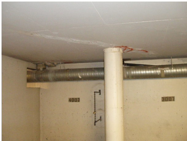
Skader i underkant dekke ved søyler
