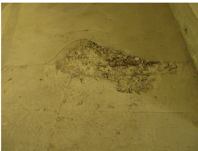
Bildene over viser noen av avdekkede skader i overkant dekke
