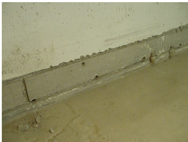
Slissing i vegger for katodisk beskyttelse av armeringen
