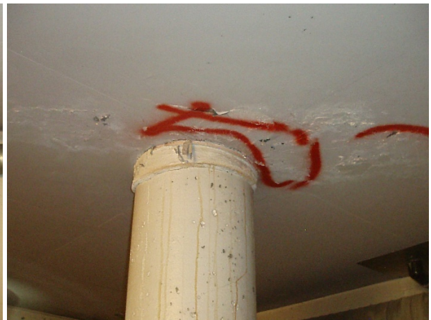
Skader i underkant dekke ved søyler
