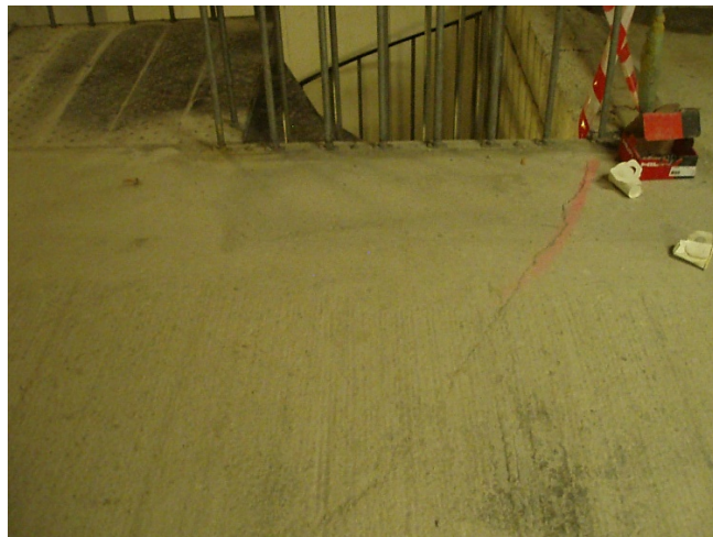
Gjennomgående riss ved trapp
