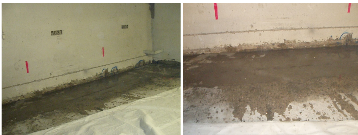
Utstøping av de største skadede områdene
