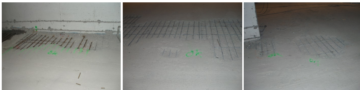
Utdrag av områder hvor armeringen er ferdig
