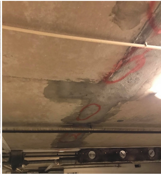
Tidligere skader er reparert
