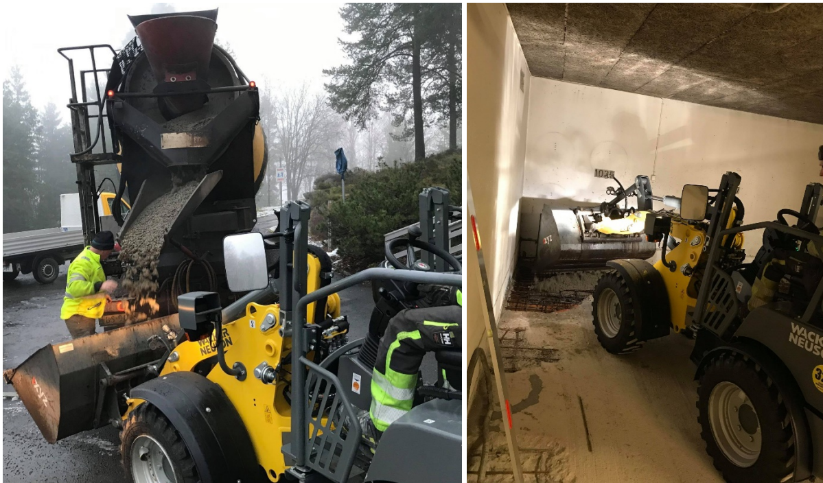
Innkjøring av betong
