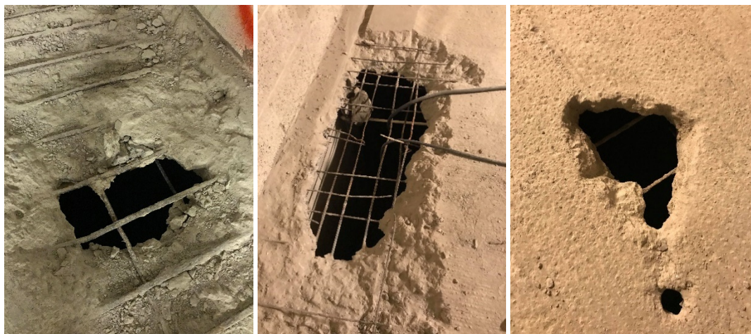
Hull i dekke og ødelagt armering
