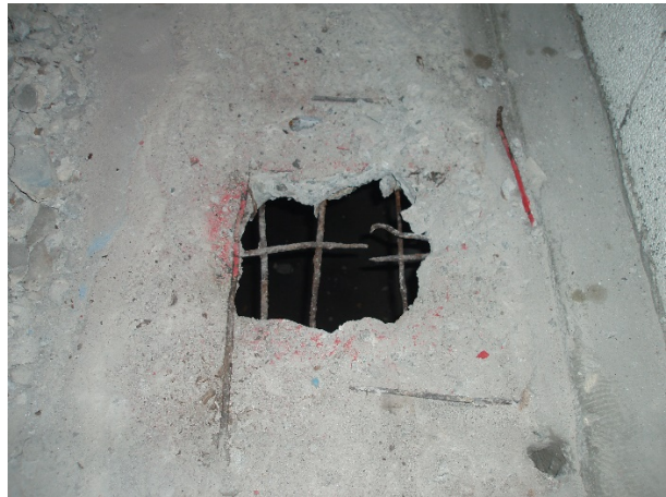
Skader i overkant armering ved opplegg
