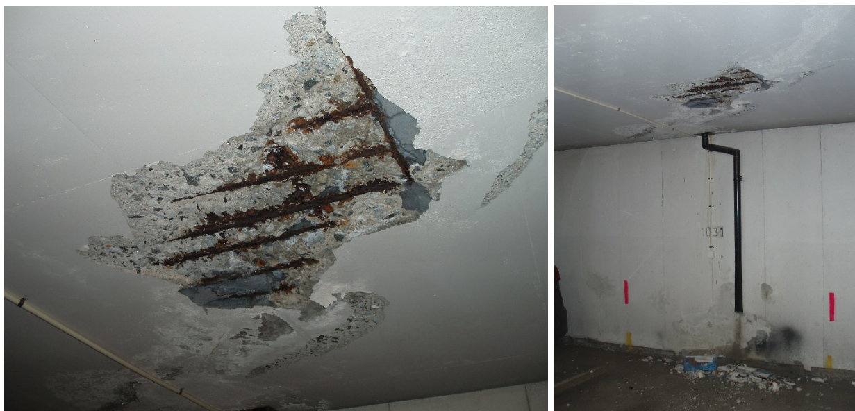
Skader i underkant dekke ved parkering 1031
