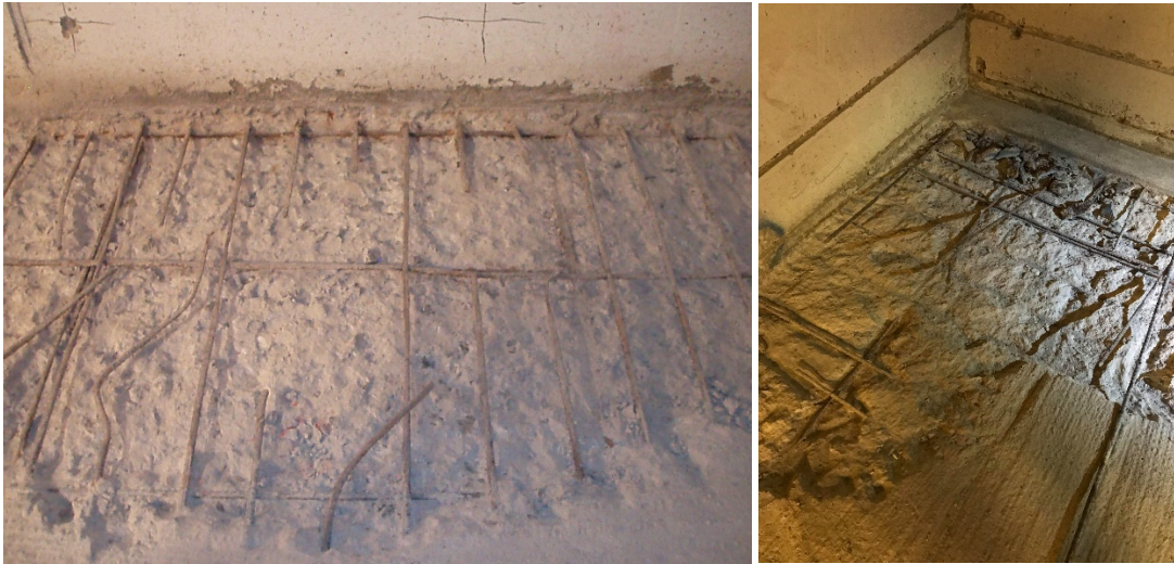
Armering i overkant er skadet og mangler delvis i områder
