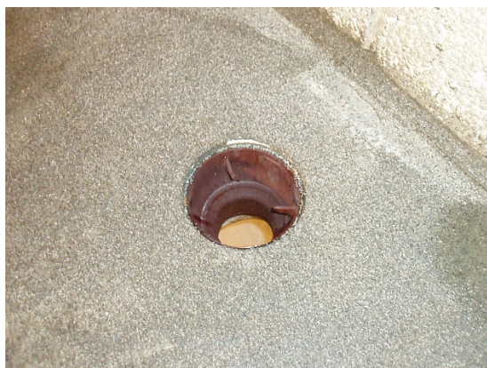
Slukgjennomføring i dekke
