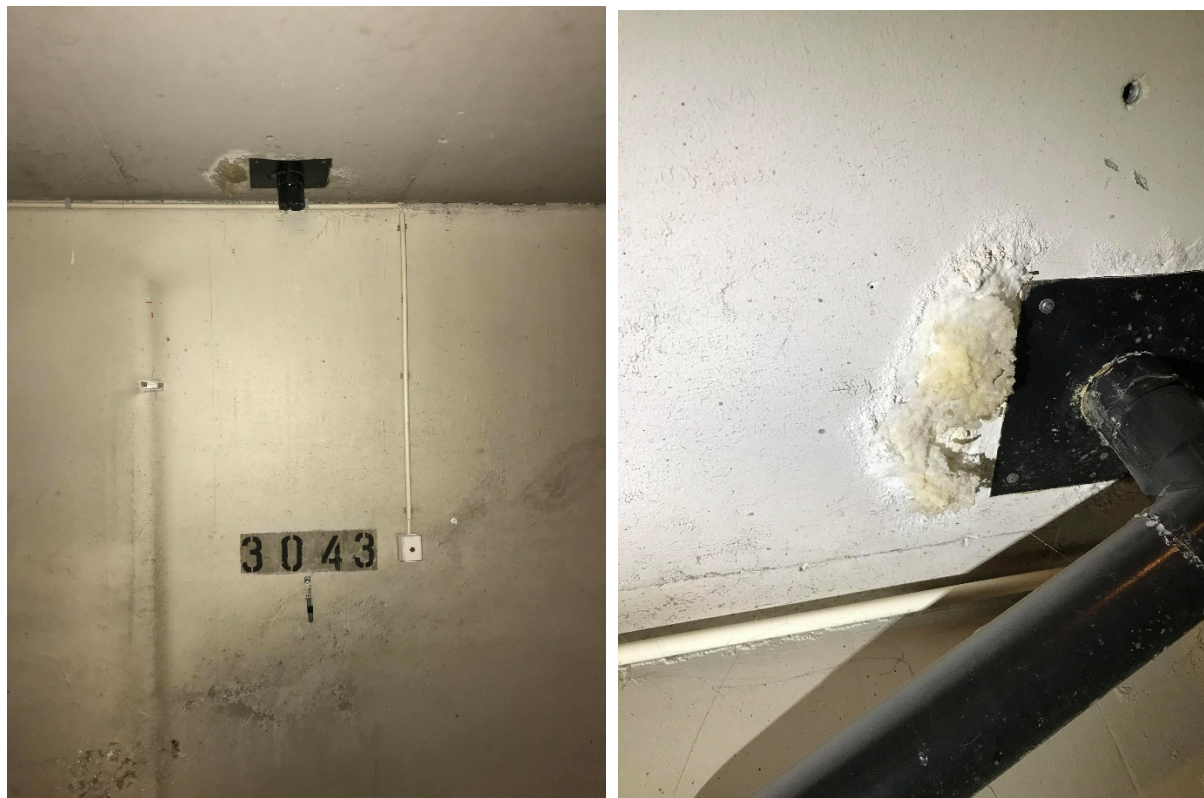
Saltutslag ved nedløp
