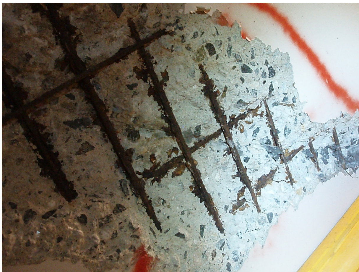
Nærbilde av skade i underkant dekke
