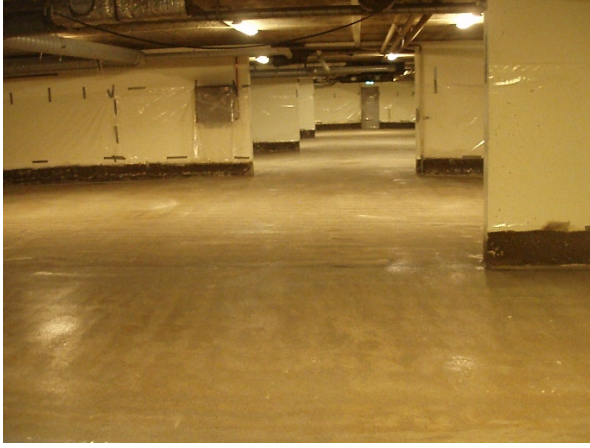
Primer påført klar for polyurea
