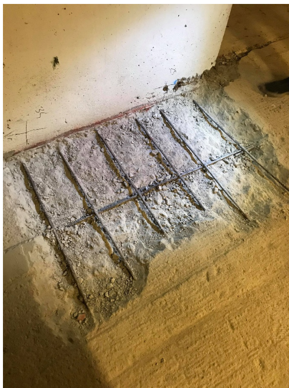
Senteravstand armering er dobbelt så stor som det vises på armerings-tegningen.
