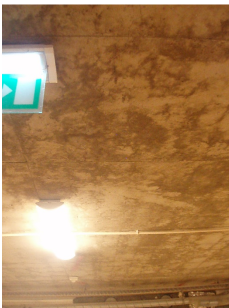
Område med riss i dekke
