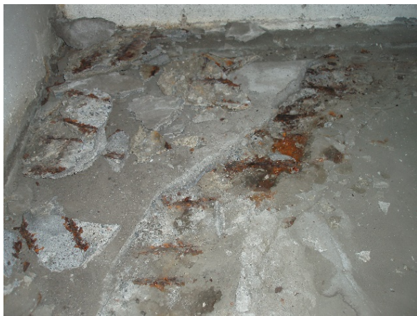
Skader i overkant armering ved opplegg
