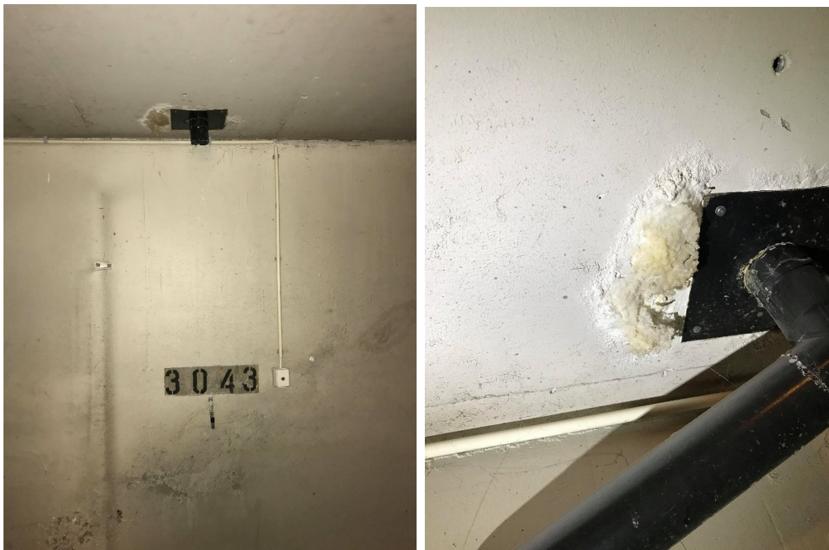
Saltutslag ved nedløp
