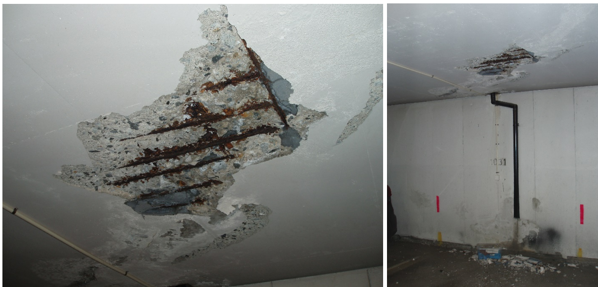
Skader i underkant dekke ved parkering 1031
