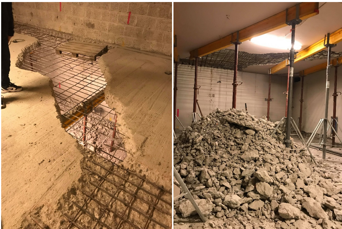
Pigging av betong pågår fortsatt i dette området, og betydelig mengder betong er tatt ned
