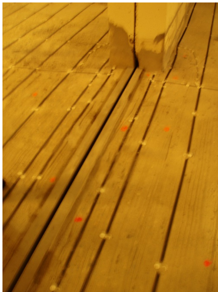
Stålvinkler ved dillatasjonsfuge
