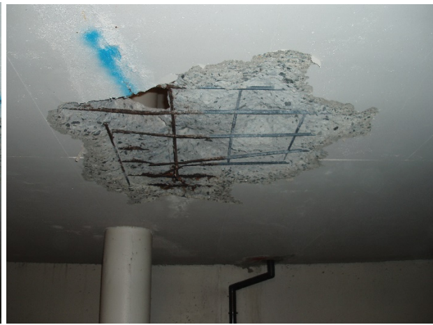
Skadet armering og "frisk" armering i underkant dekke
