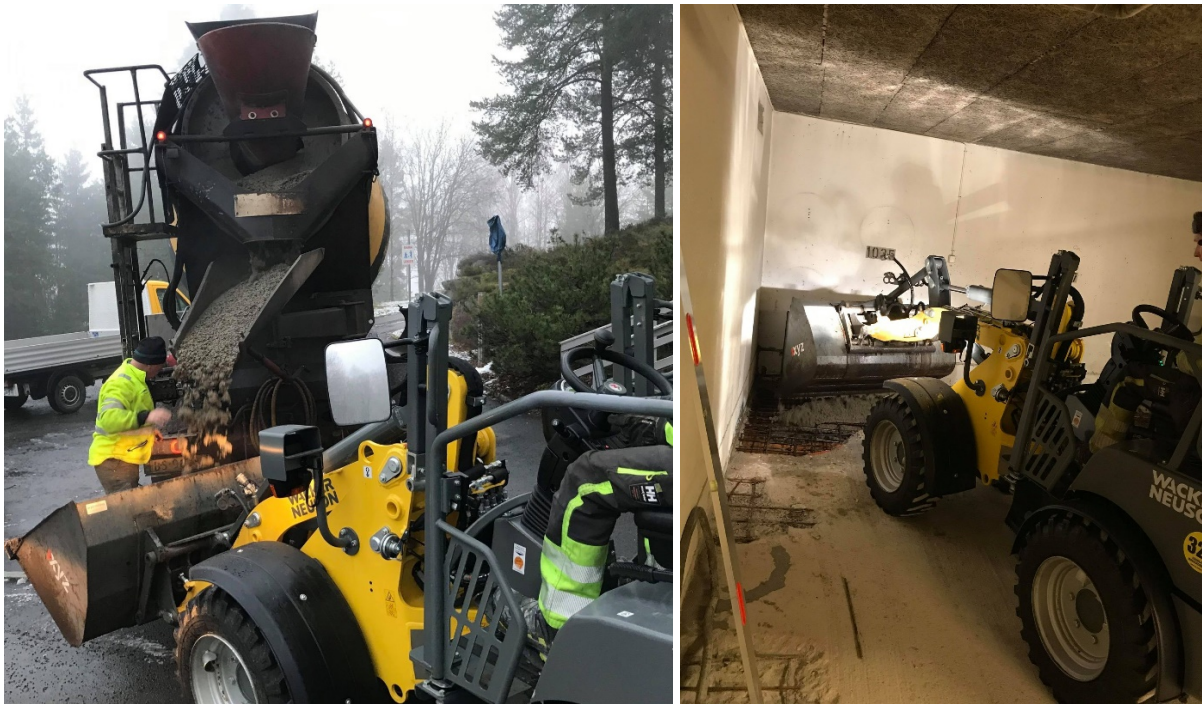
Innkjøring av betong
