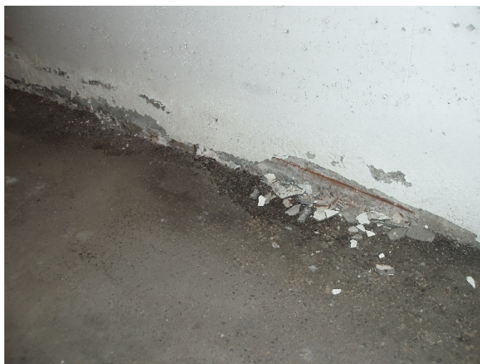
Skader på vegger
