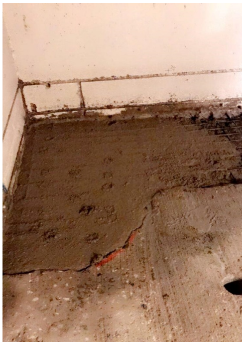
Lite hjørne snart ferdig utstøpt.
