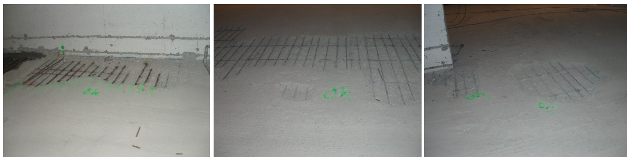
Utdrag av områder hvor armeringen er ferdig
