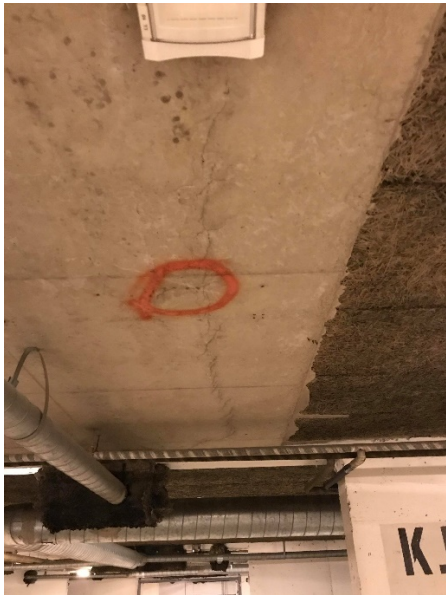
Riss i dekke
