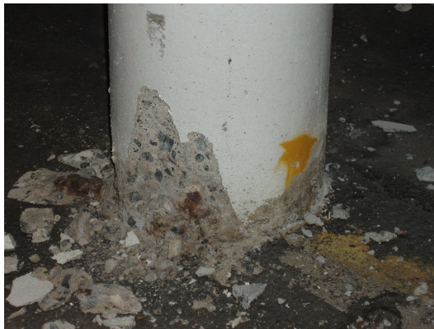
Søyle med skader
