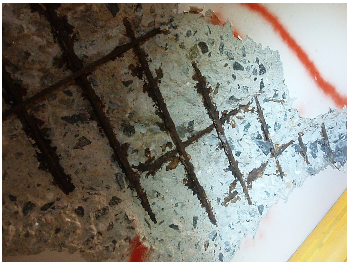
Nærbilde av skade i underkant dekke
