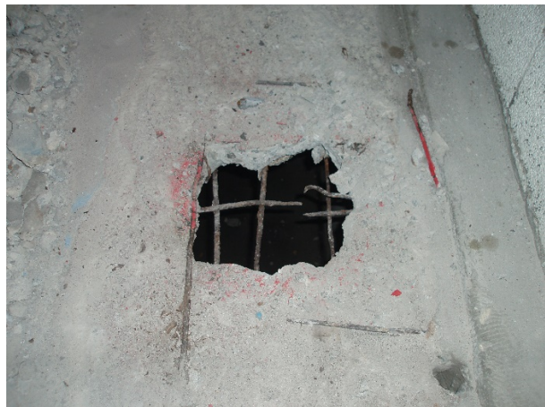
Skader i overkant armering ved opplegg
