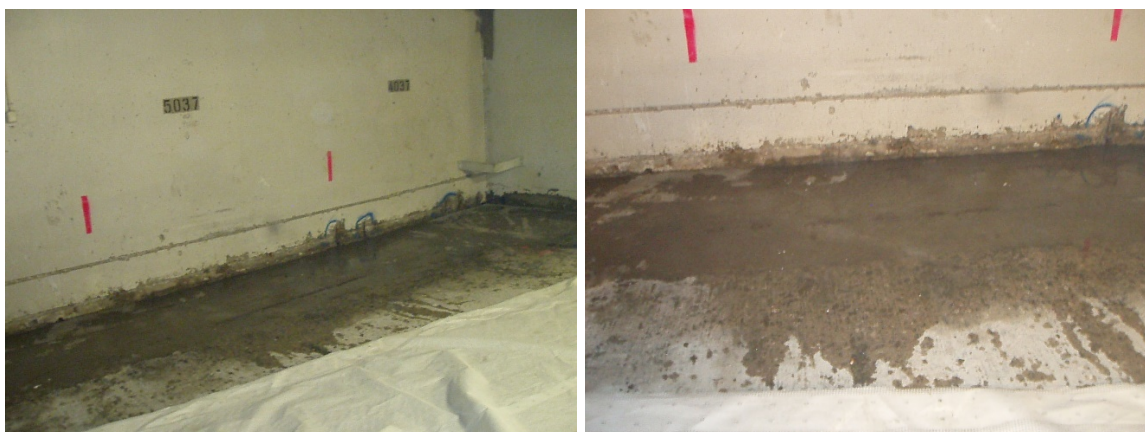
Utstøping av de største skadede områdene
