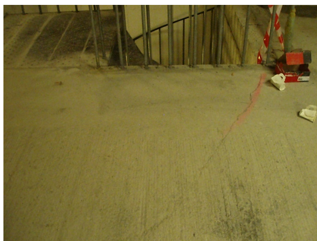
Gjennomgående riss ved trapp
